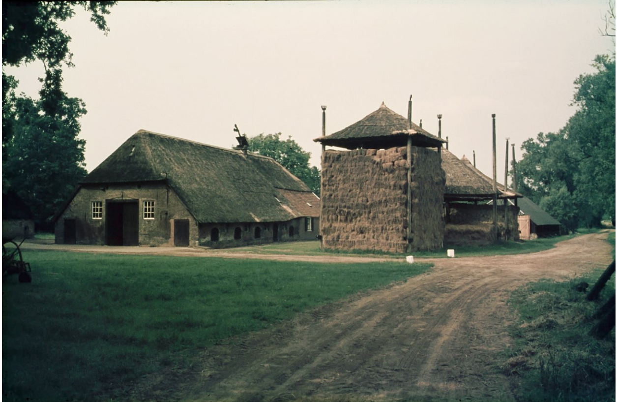
Fig. 5. Groot Hell met de drie hooibergen circa 1975. Let op de gek op de schoorsteen die met de windrichting meedraait en valwind in de schoorsteen tegengaat.
